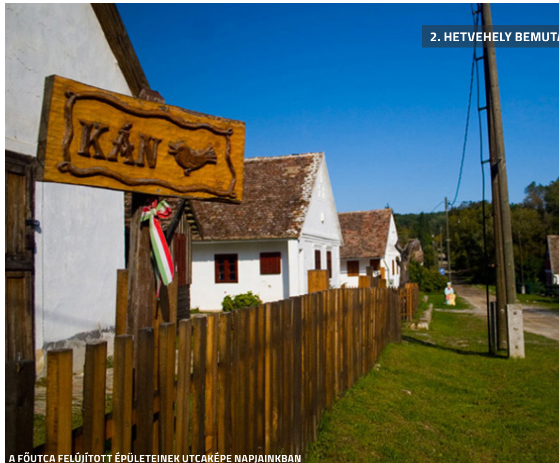
A FŐUTCA FELÚJÍTOTT ÉPÜLETEINEK UTCAKÉPE NAPJAINKBAN
